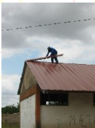
Ricostruzione del tetto della scuola di Machava
